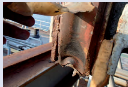
舱盖板密封橡皮垫圈损坏且其有超过制造商建议值的永久变形现象。密封橡皮槽严重腐蚀。
