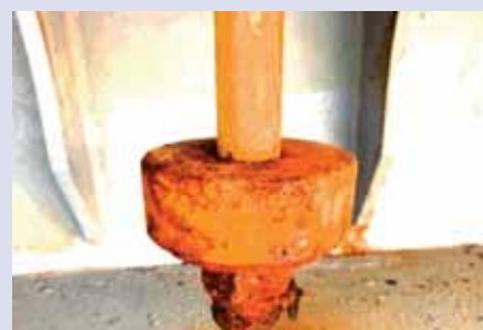
Trinca de bodega apretada y pintada por encima.
