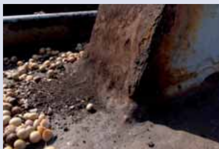
Brazola sin barrer, restos de carga y roña evidentes. El canto de la junta de cierre central muestra severas deformaciones.
