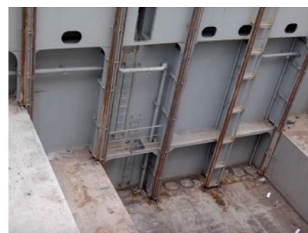
Mamparo de popa en bodega nº 4
