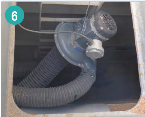
写真6: マンホールに設置された拡散ファン。米国やインドなど各国でこうした方式が採られている
