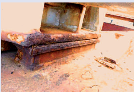
腐食し衰耗したハッチカバーランディングパッド
