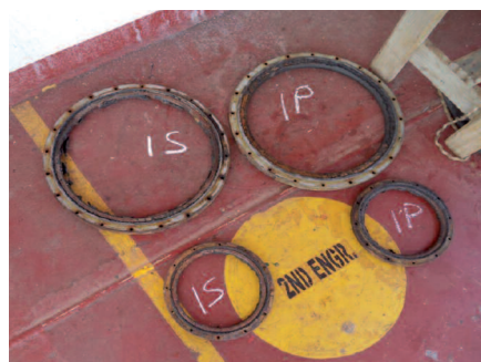
貨物の腐食性が原因で損傷した'O'リング
