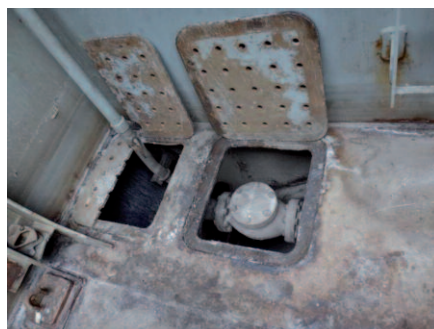
右舷ビルジ溜まり
