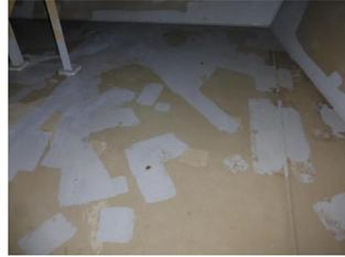
破裂部分を補修した様子
