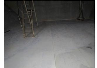
ケイ酸亜鉛コーティングは溶剤をはじめとする化成品への耐性が強く、他のコーティングのプライマーとして使われることもあります。ただし、塗装前にクリーニングやブラストなど表面の下地処理をきちんと行っておかないと、うまく接着せず、コーティングが破損してコンタミリスクが高まります。亜鉛コーティングをプライマーにする場合、上塗りコーティングとの相性が悪いとコーティングが破損し、輸送中に貨物が劣化してクレームを受けるおそれがあります。
